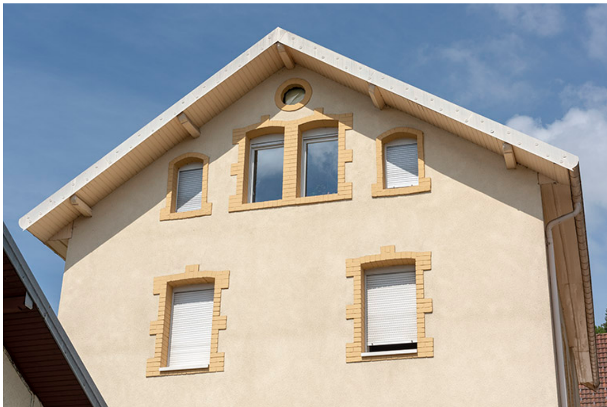
Façade latérale gauche : pignon avec fenêtre horlogère.
