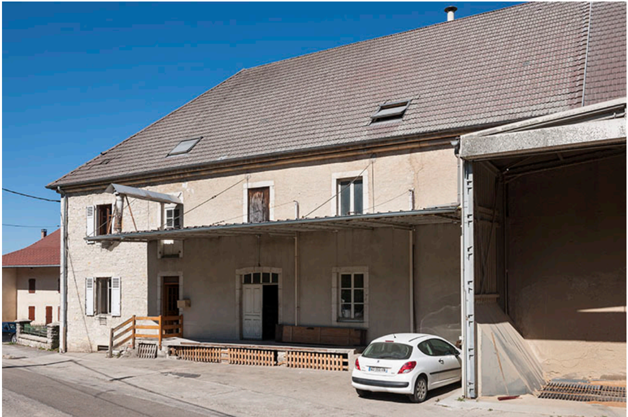
Façade sud-est de la minoterie.
