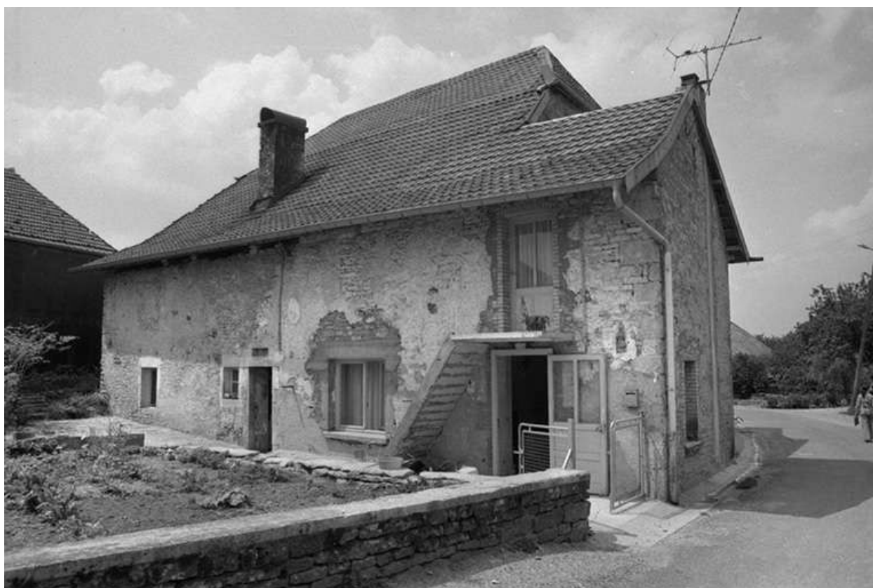
Ferme cadastrée 1965 ZM 103 : vue générale.
