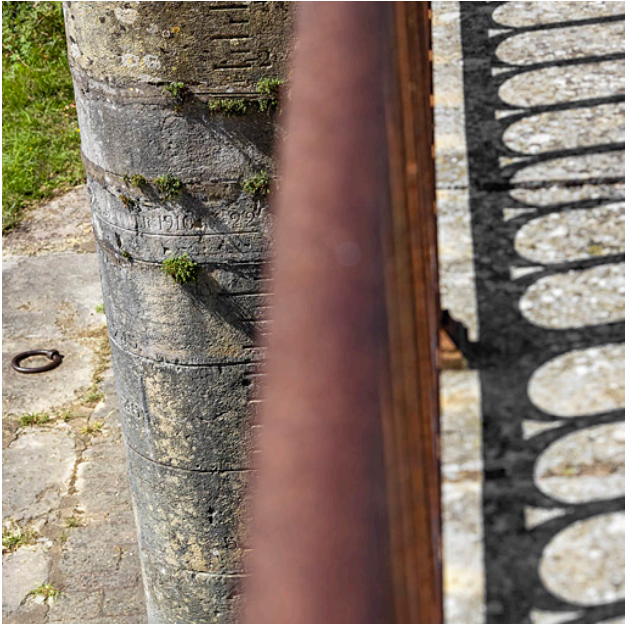
Echelle de crue sur la culée du pont.
