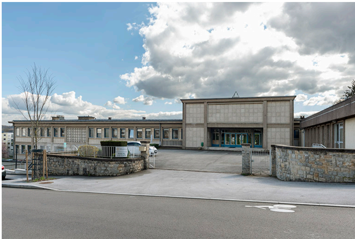
Façade antérieure et entrée.
