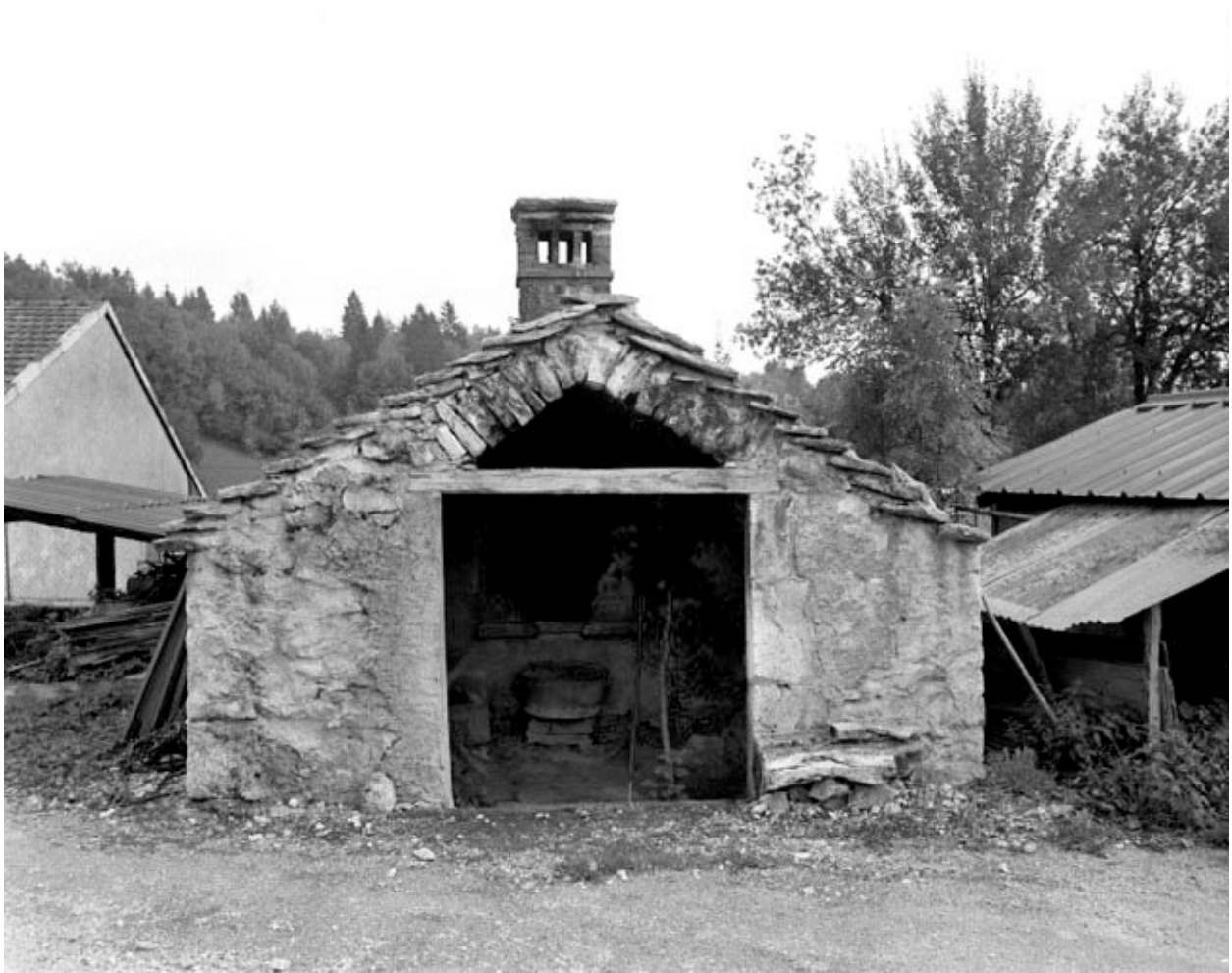
Viry, ferme située au lieu-dit Sièges : façade antérieure du fournil.
