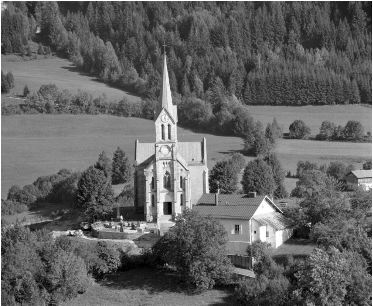
Extérieur : vue générale de la façade ouest.
