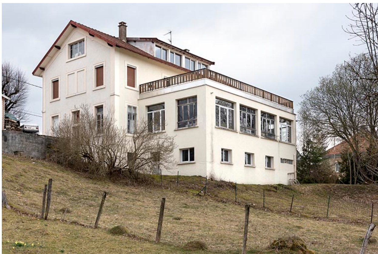
Façades postérieure et latérale droite.
