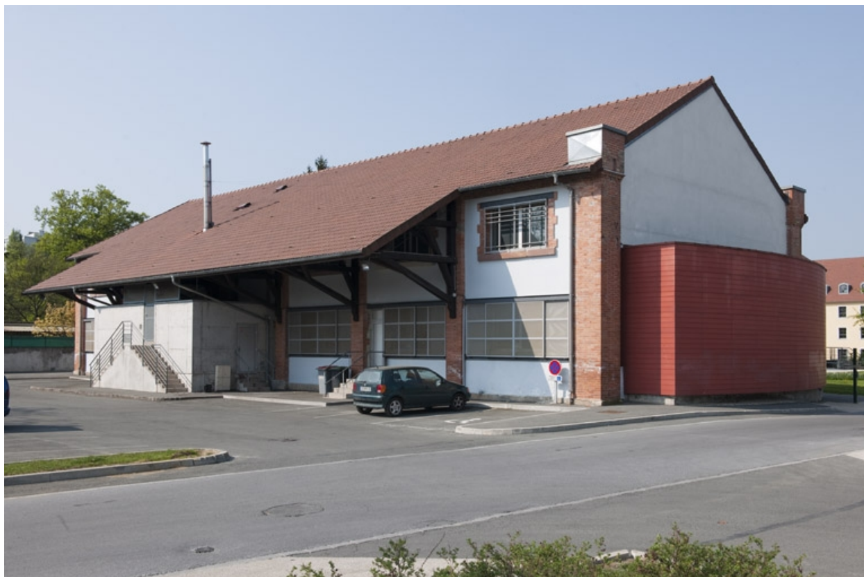
Entrepôt industriel à l'entrée du site.
