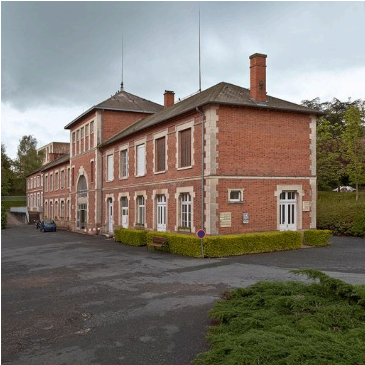
Bâtiment de services.
