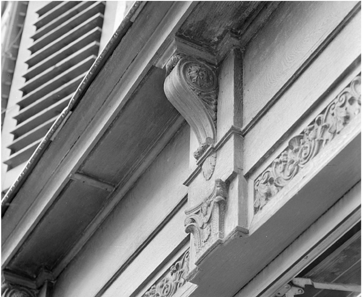
Façade sur rue, vestige de l'ancienne devanture.
