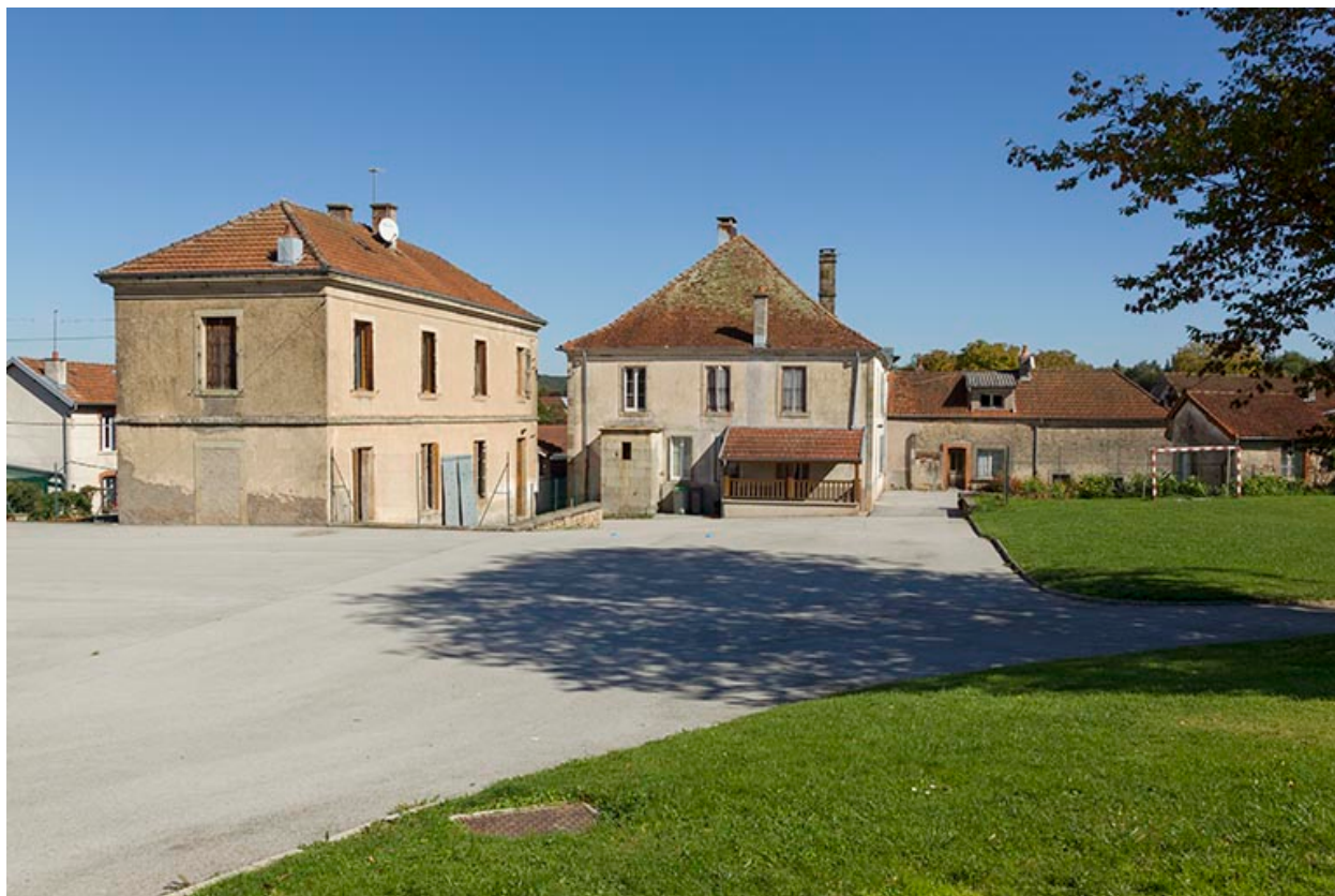
Façades sud et est de l'école.
