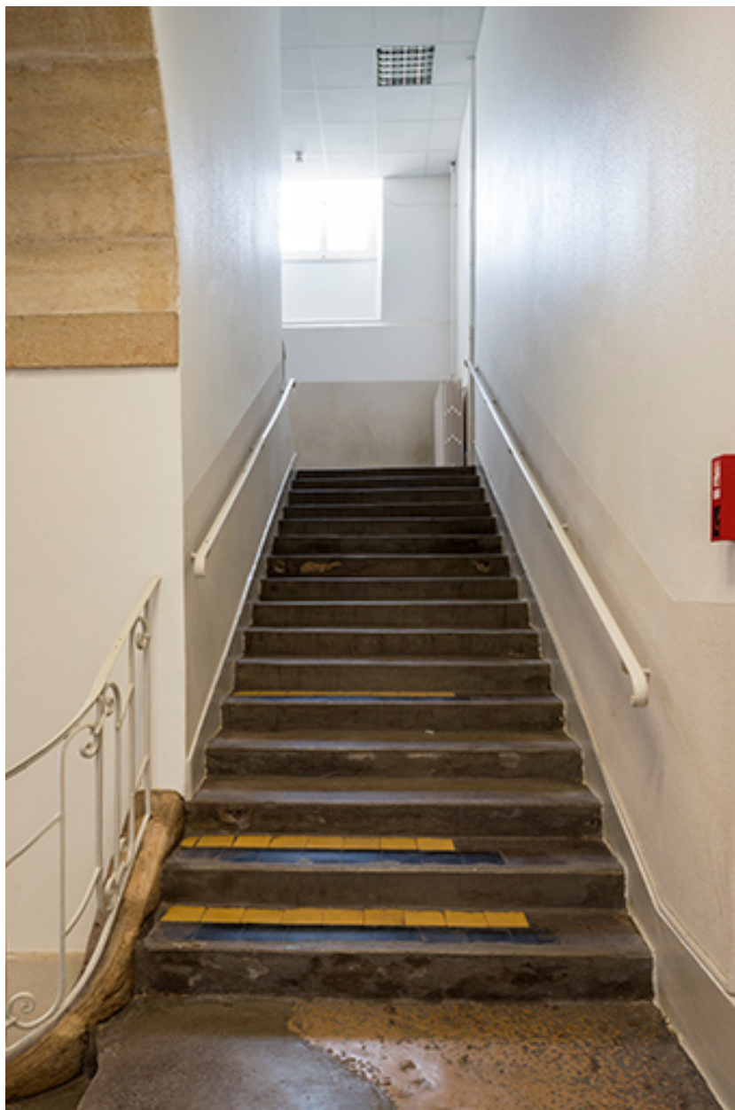
Détail d'escalier dans le hall d'entrée.
