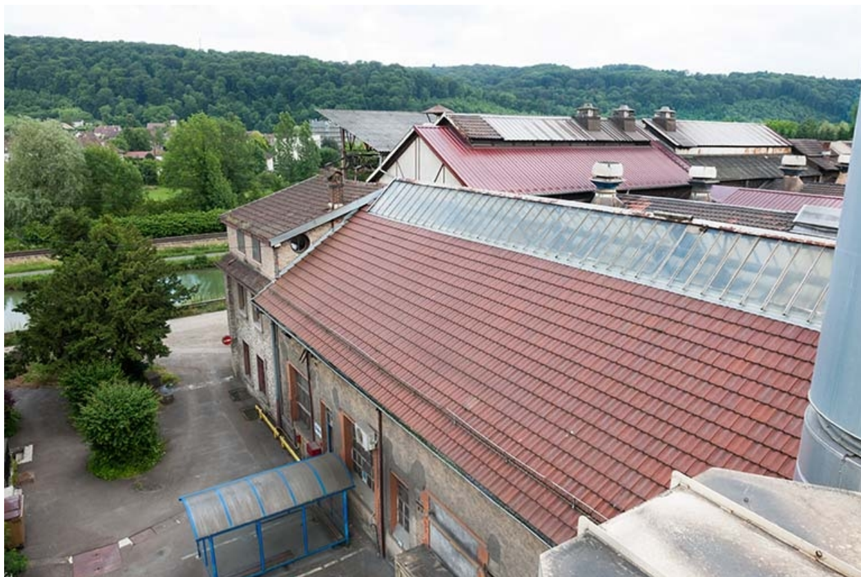
Vue plongeante sur l'ancien atelier de noyautage.
