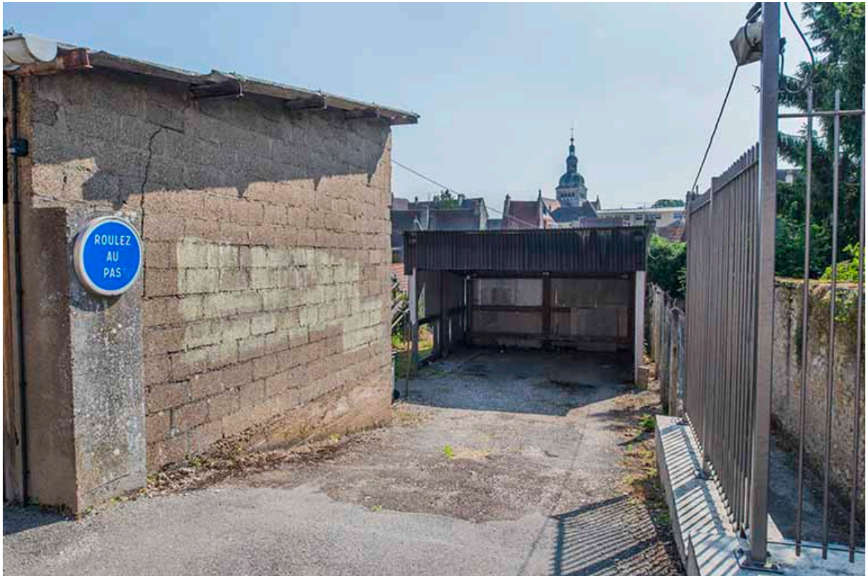
Détail de façade sud des garages et entrée ouest du garage des ouvriers.
