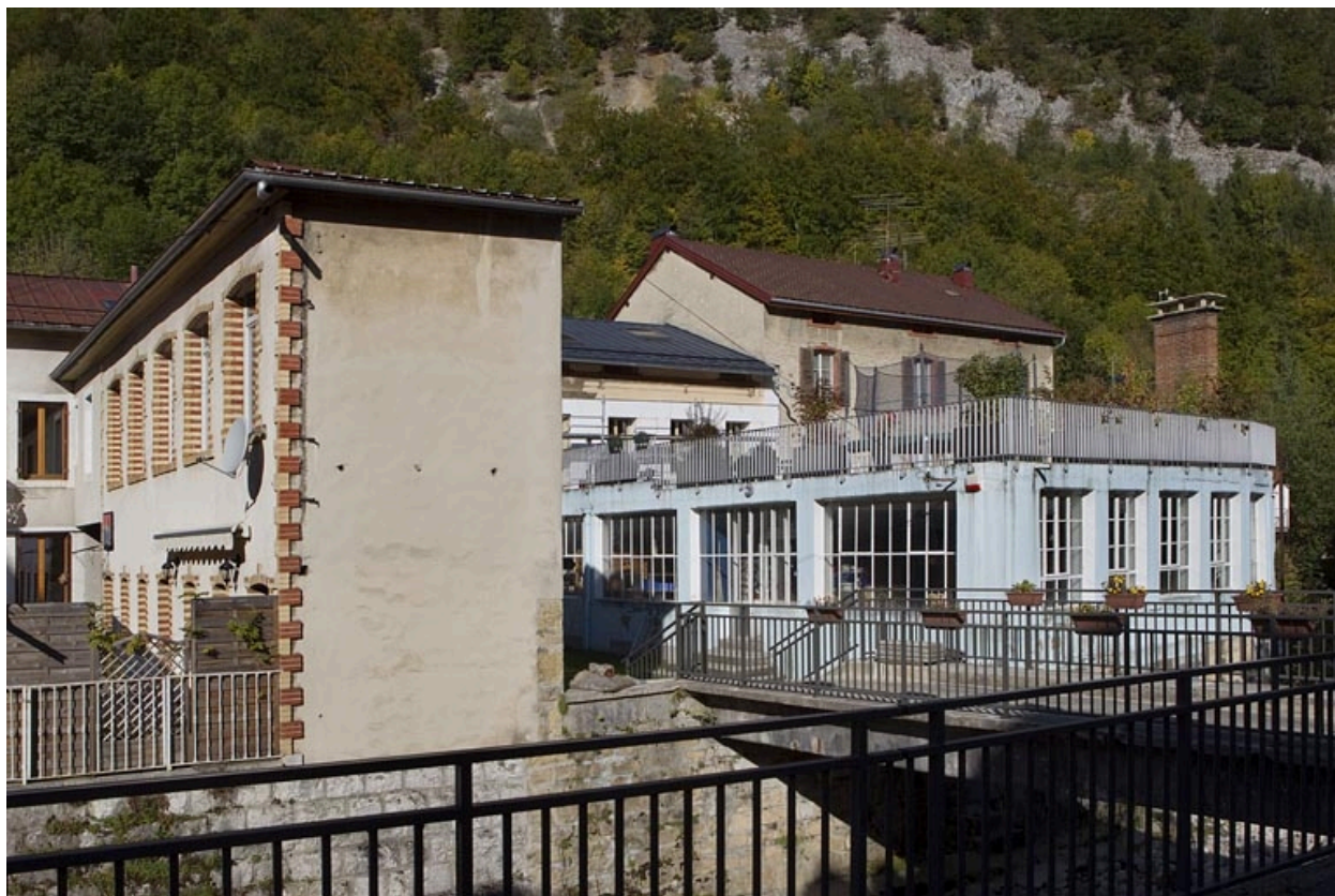
Usine Poux puis Chevassus, Morez (90 rue de la République et 11 rue de l'Industrie).
