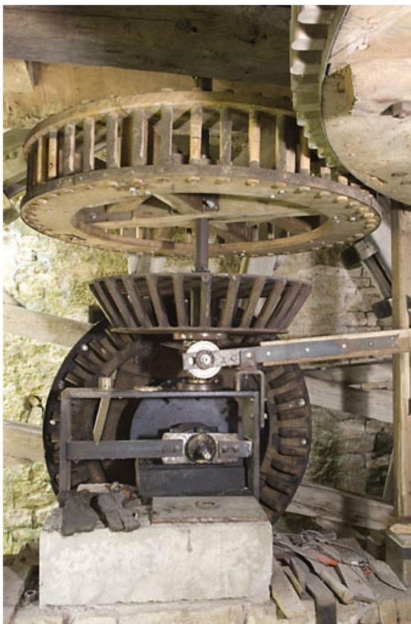
Détail des éléments de transmission (roues dentées et lanternes).
