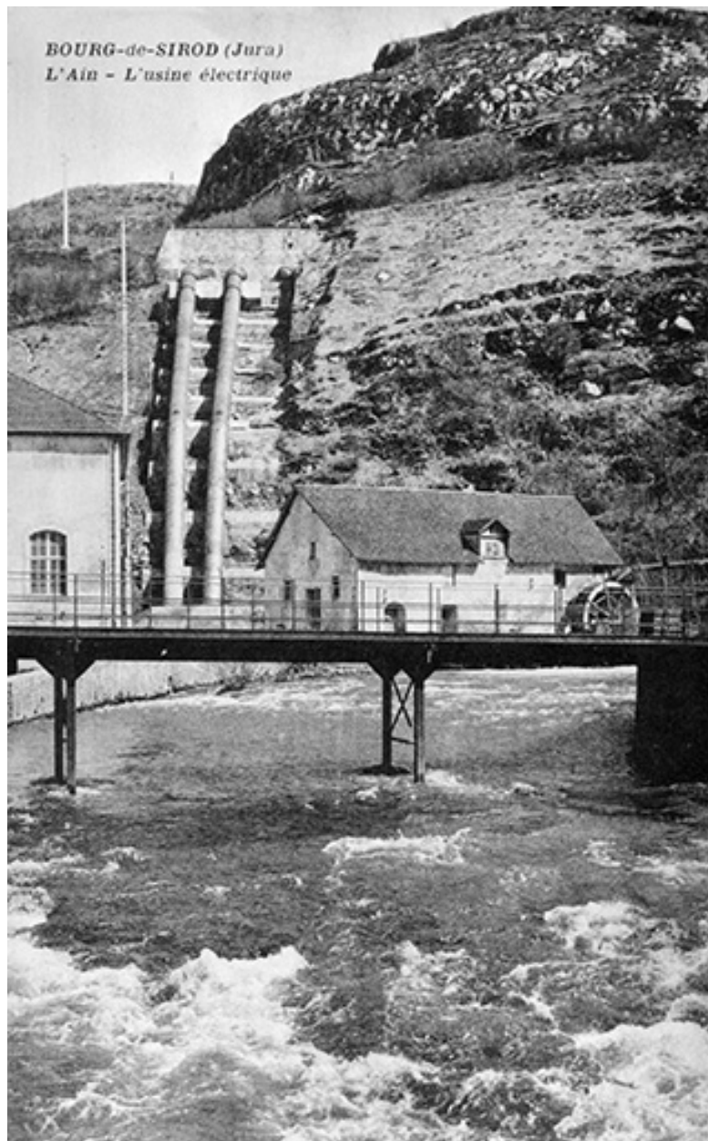
Bourg-de-Sirod (Jura). L'Ain - L'usine électrique.
