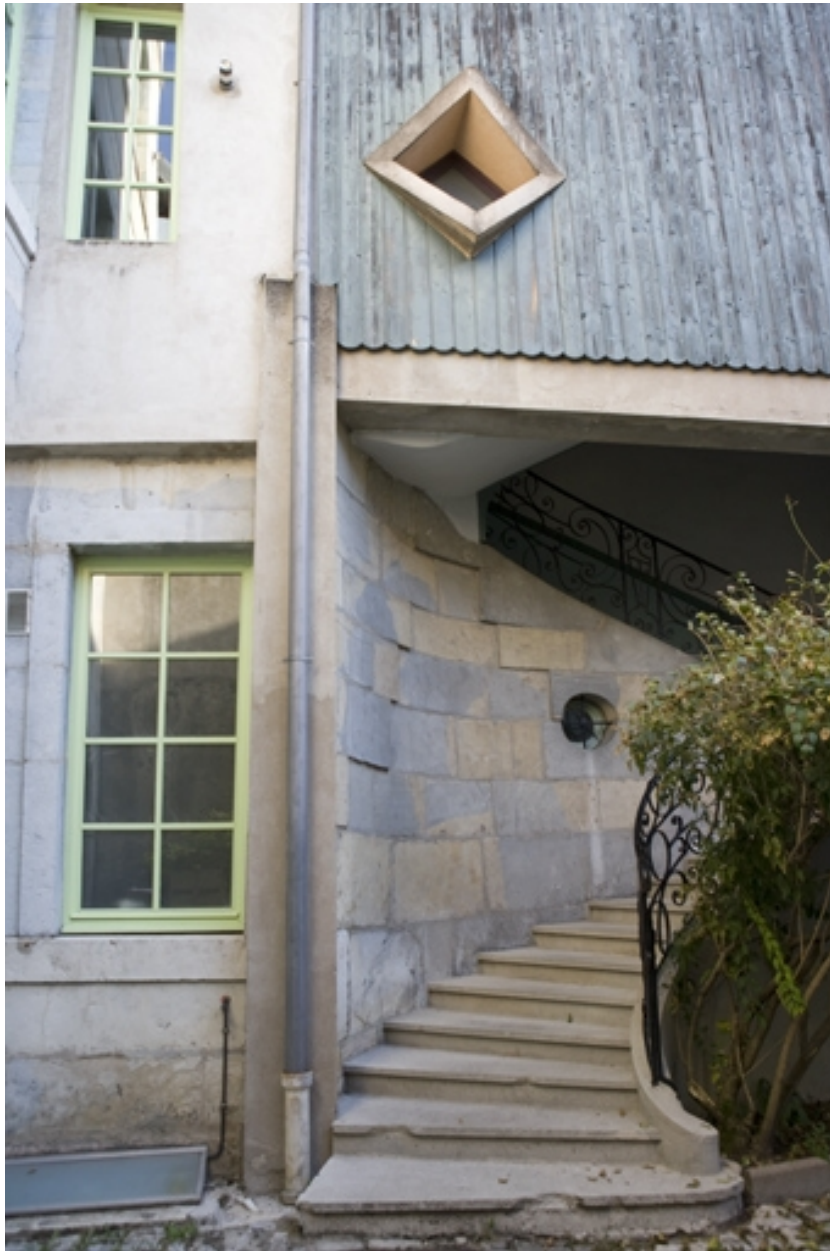
Détail du départ de l'escalier à cage ouverte sur cour, vue verticale.
