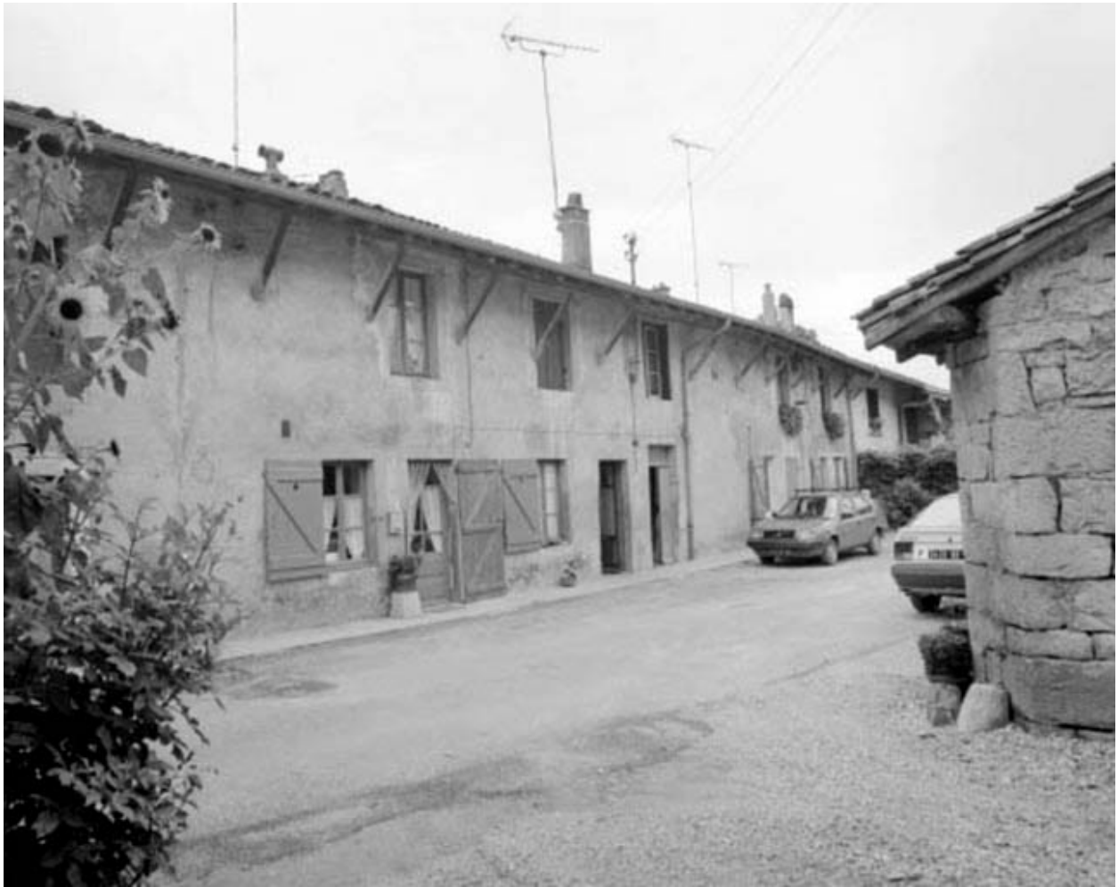
Logement d'ouvriers (O).
