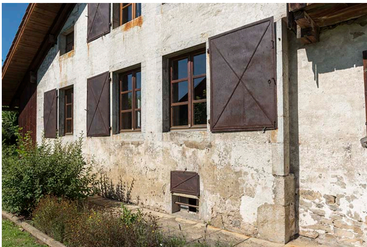
Corps sud-est et ses volets métalliques.
