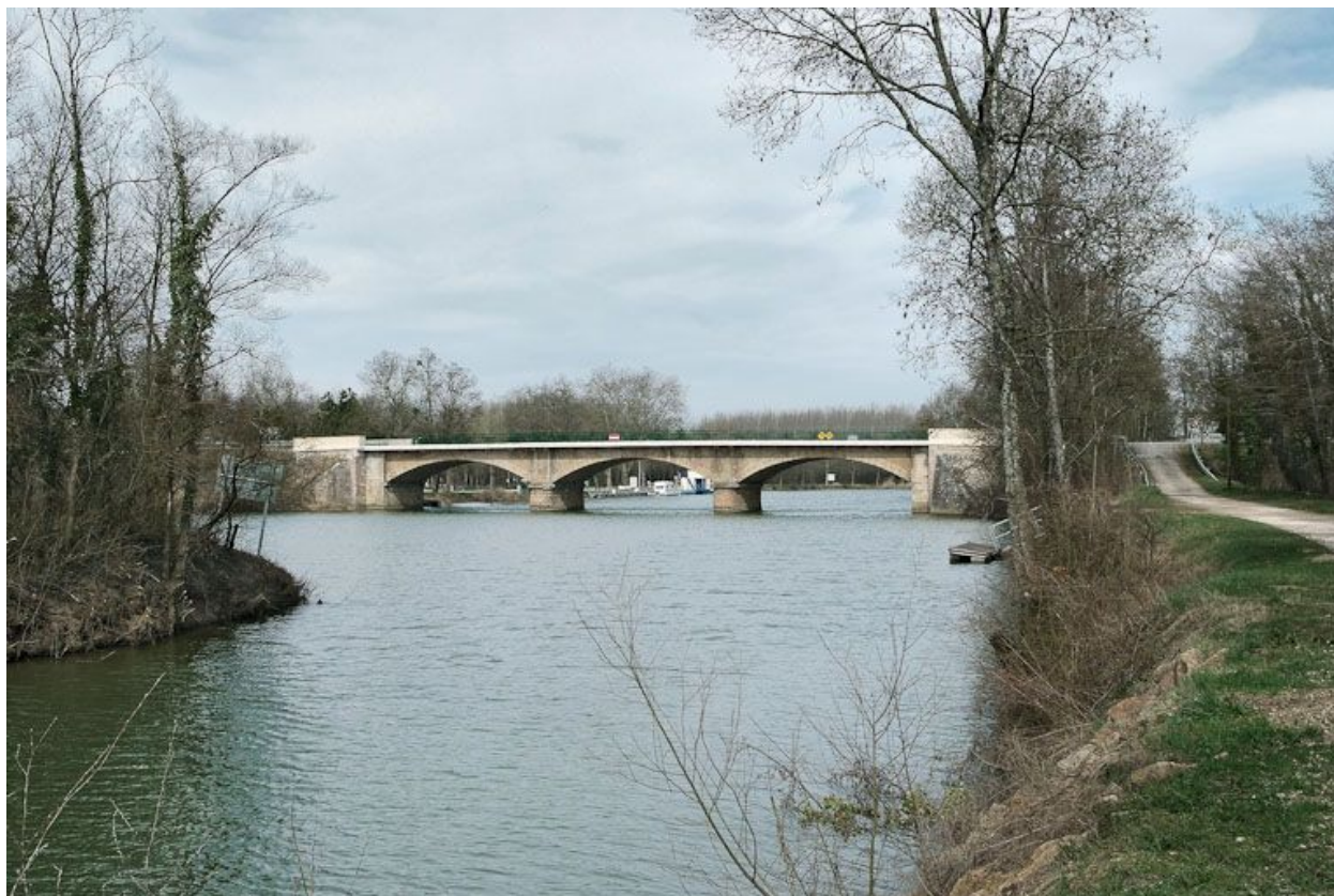
Le pont de Cuisery, vu d'amont.
