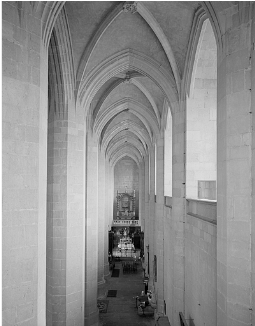
Vue du collatéral sud vers l'est depuis la coursière basse.
