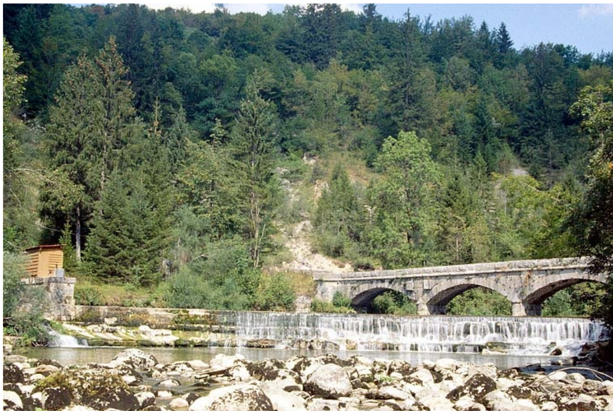
Le barrage, vu de l'aval.
