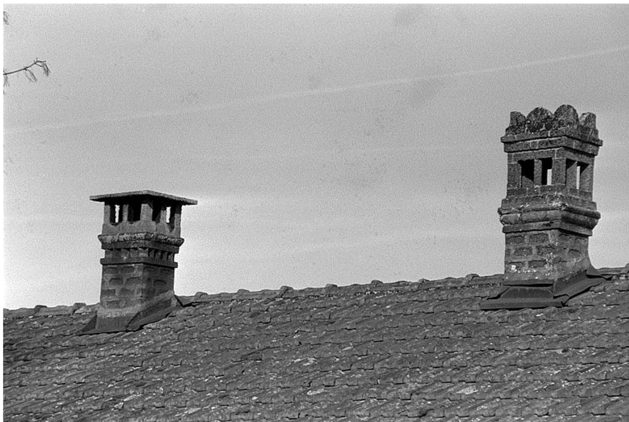
Souches des cheminées du logement.
