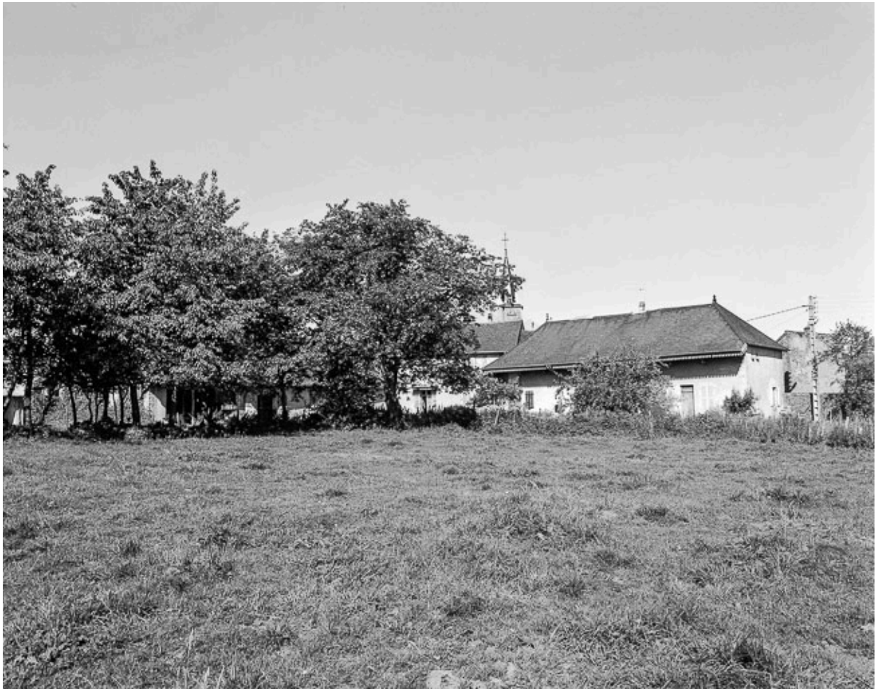
Maison cadastrée AC 251 : vue éloignée.
