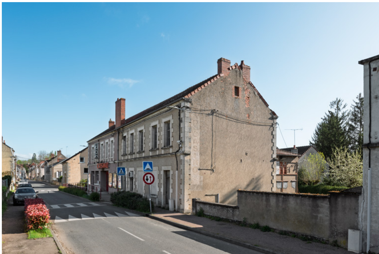
Vue d'ensemble, depuis le sud (façade antérieure).
