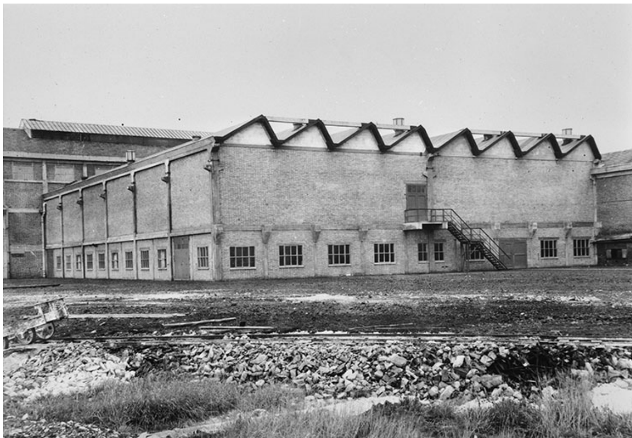
Usine d'électrolyse, Salle 2 : bâtiment des cellules.
