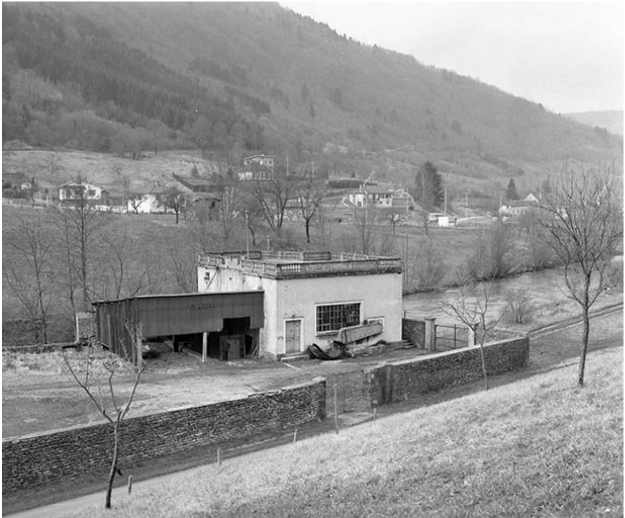
La centrale hydroélectrique en 1982, vue depuis le sud-est.
