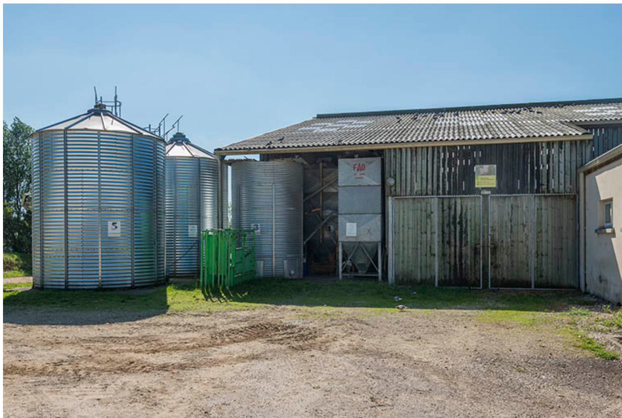
Angle nord-est du bâtiment de production laitière.
