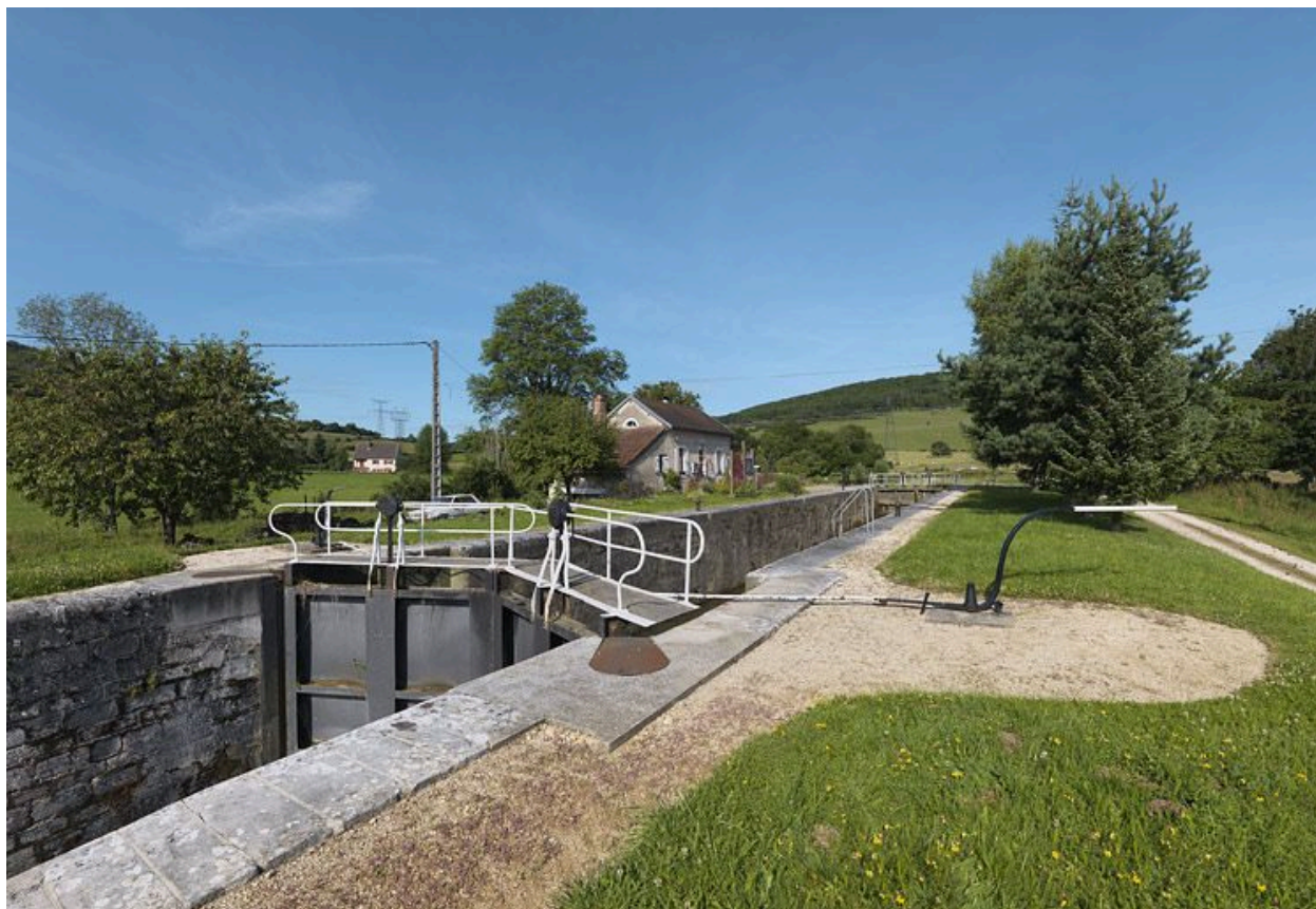
Vue aval du site d'écluse 16.
