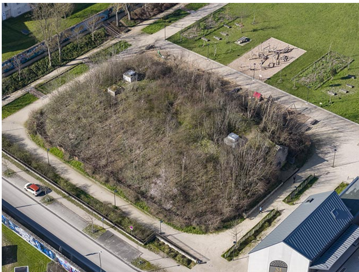
Le magasin V1. (vue aérienne).
