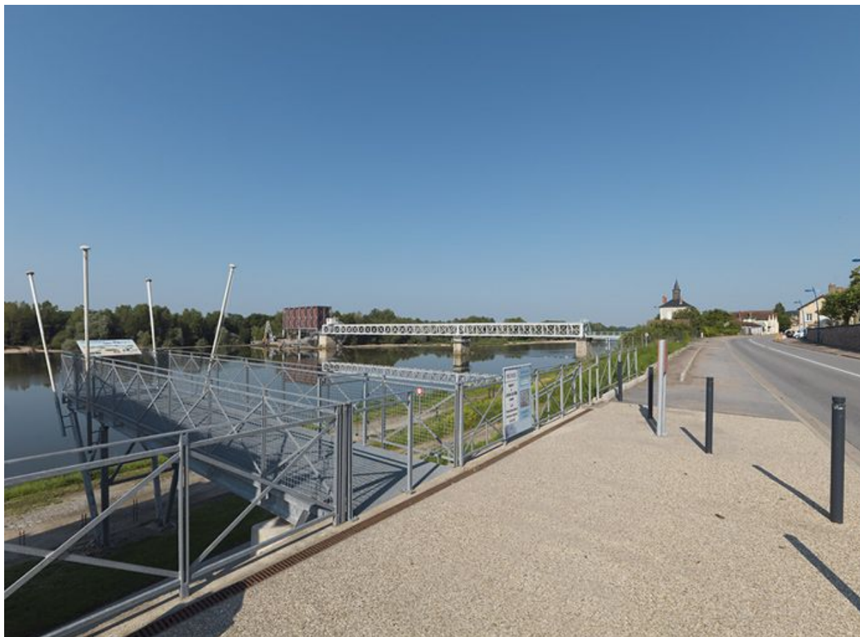
Vue d'ensemble du barrage.
