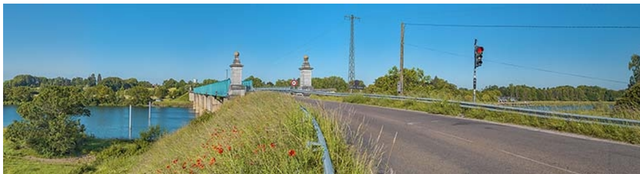
Pont Boucicaut, depuis Verjux.
