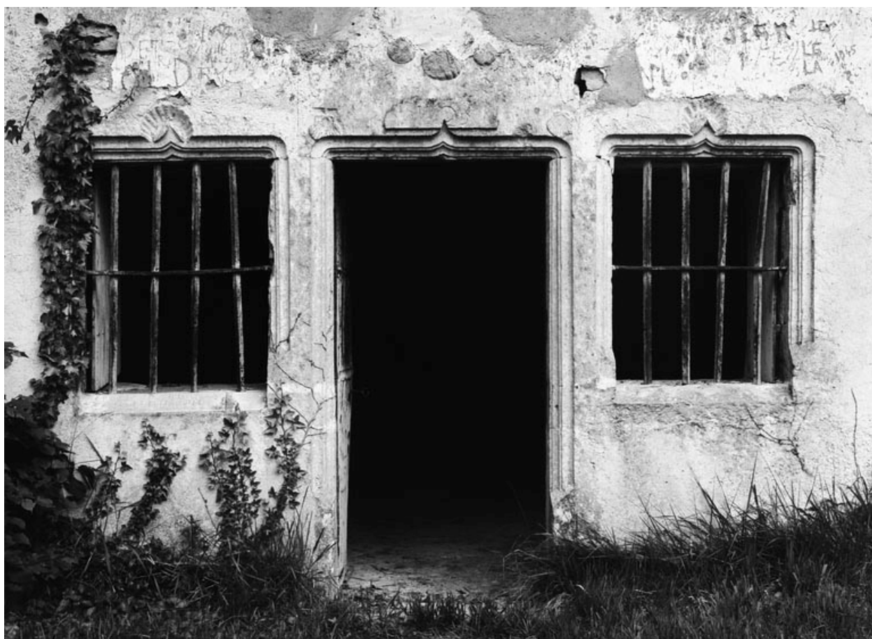
Détail des ouvertures.
