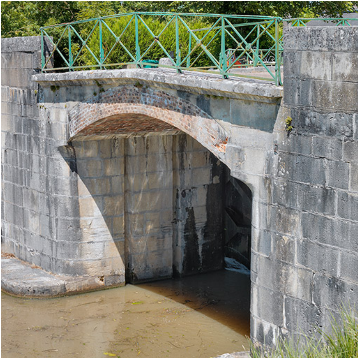
Vue rapprochée de la voûte en brique.
