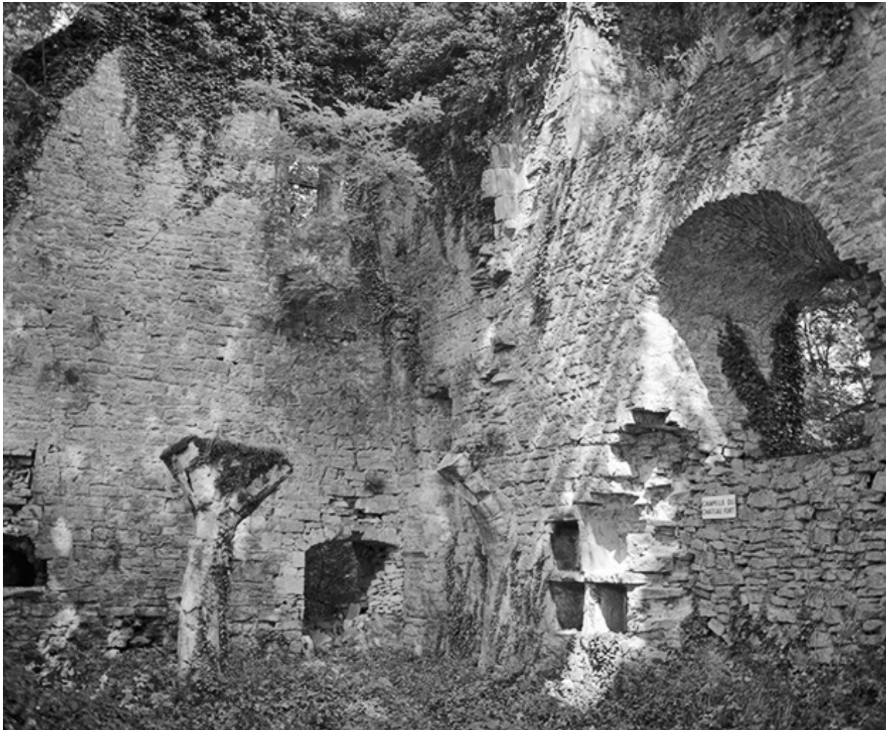
Chapelle du château, vue intérieure.
