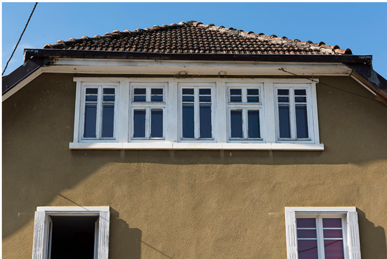
Façade latérale gauche : fenêtres multiples.
