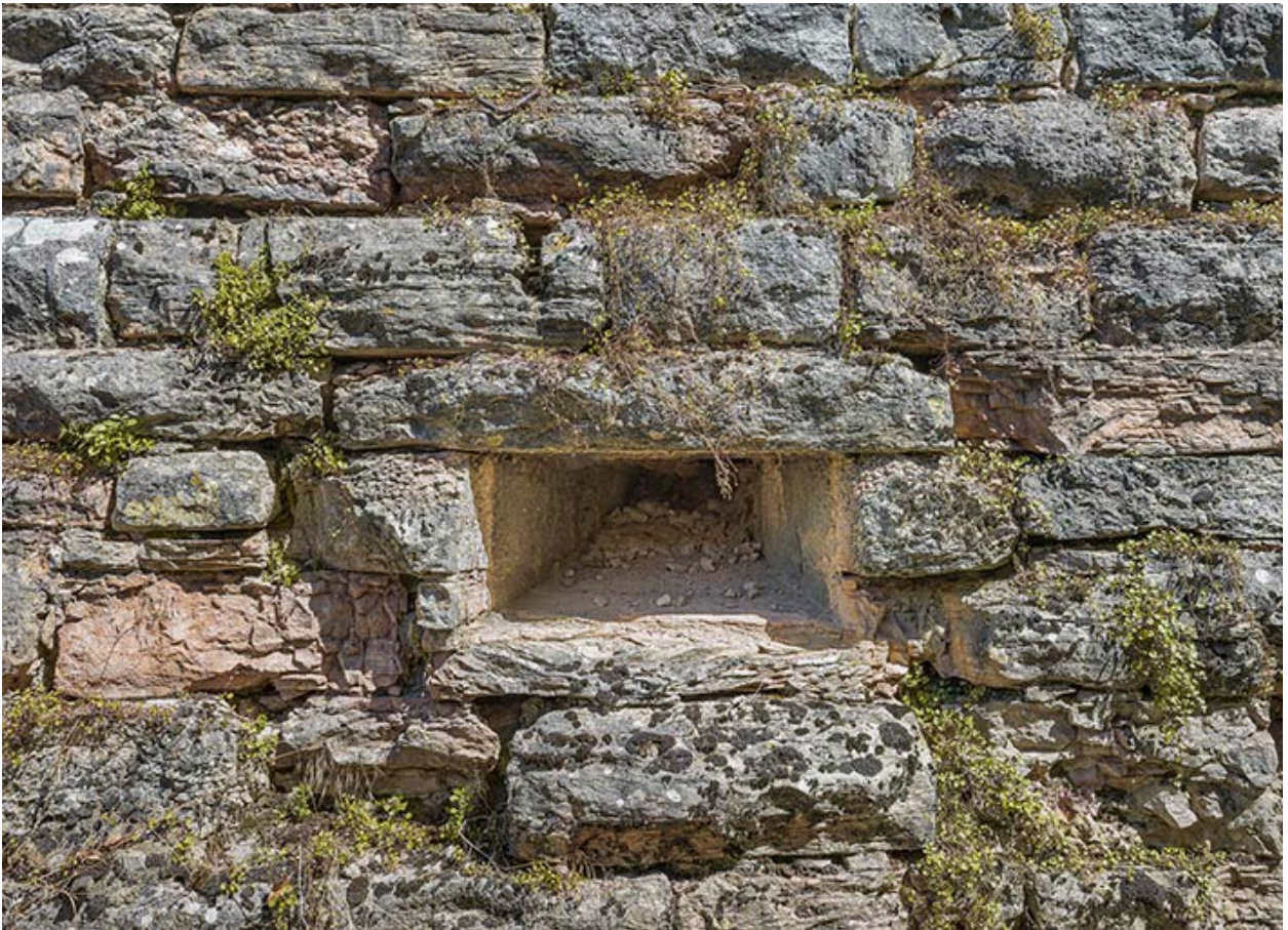
Ouverture de tir au flanc du bastion (galerie de contrescarpe).
