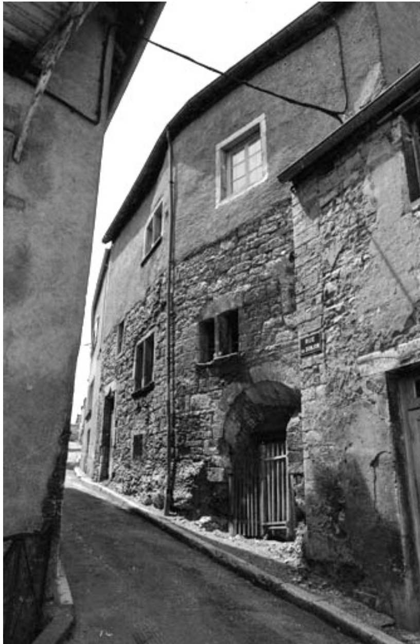
Maison située rue du Donjon : façade antérieure.
