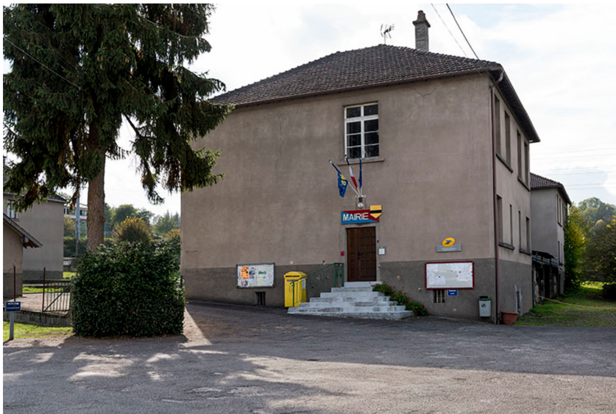
Pignon d'entrée nord-est de la mairie.
