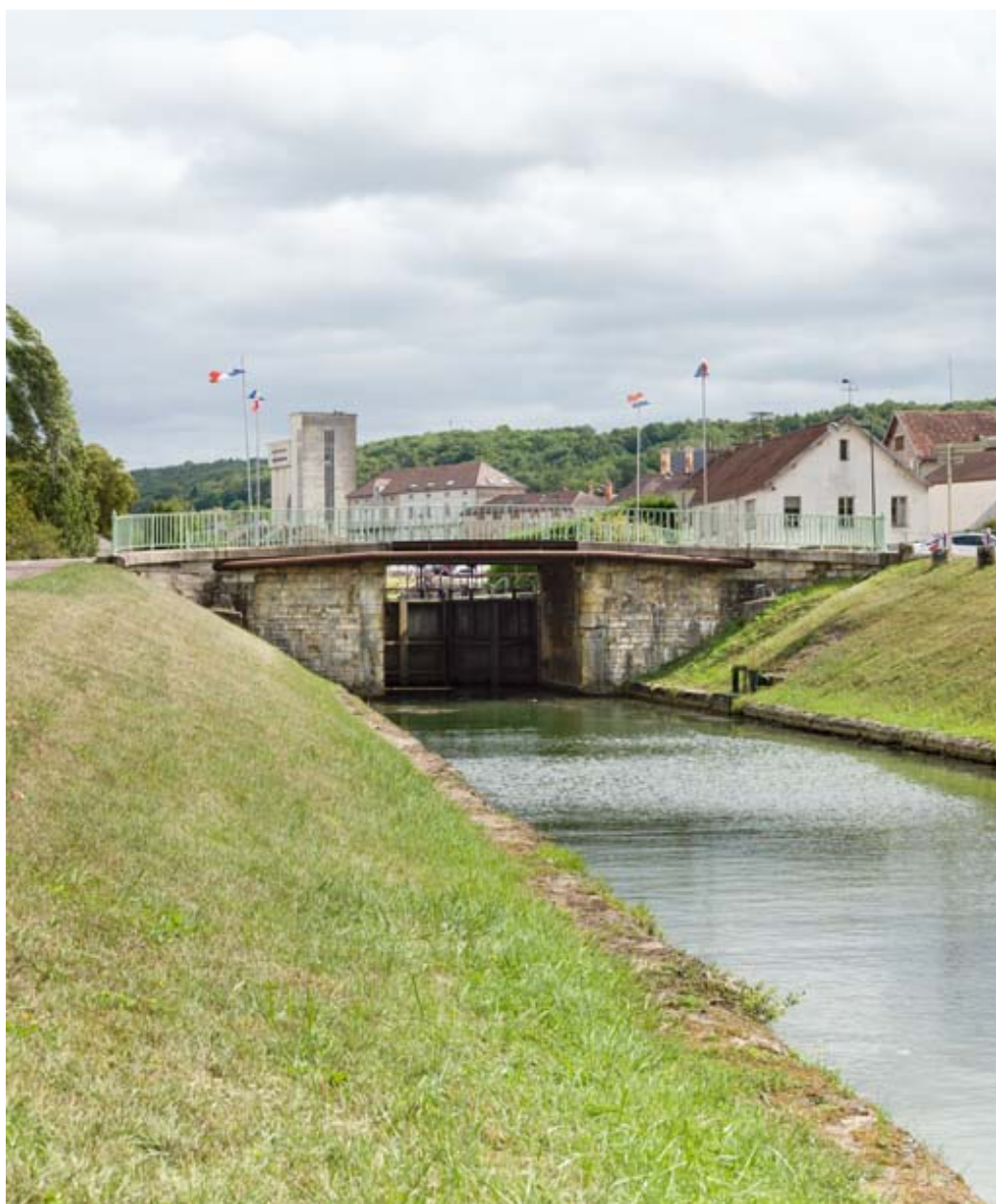
Vue d'ensemble du pont (en 2017).
