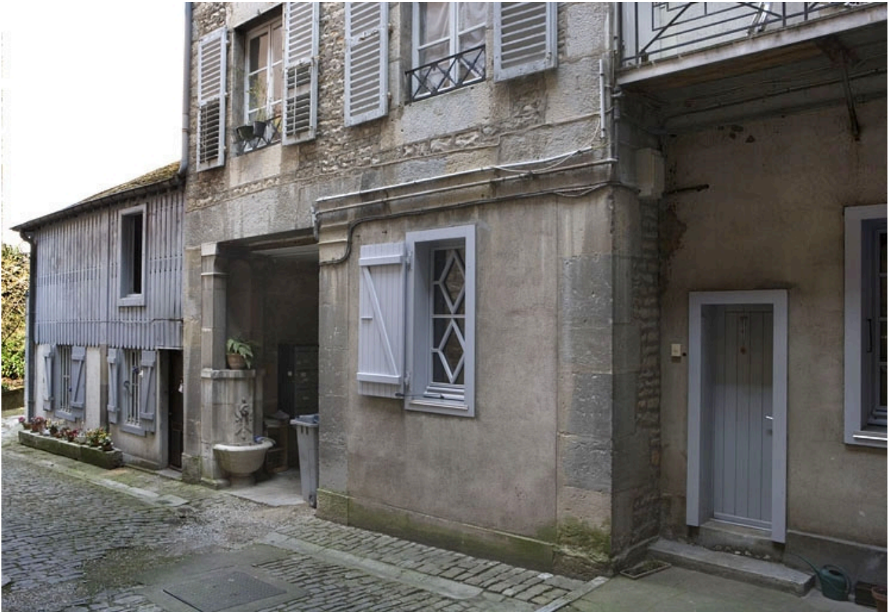
Détail du rez-de-chaussée de l'aile droite.
