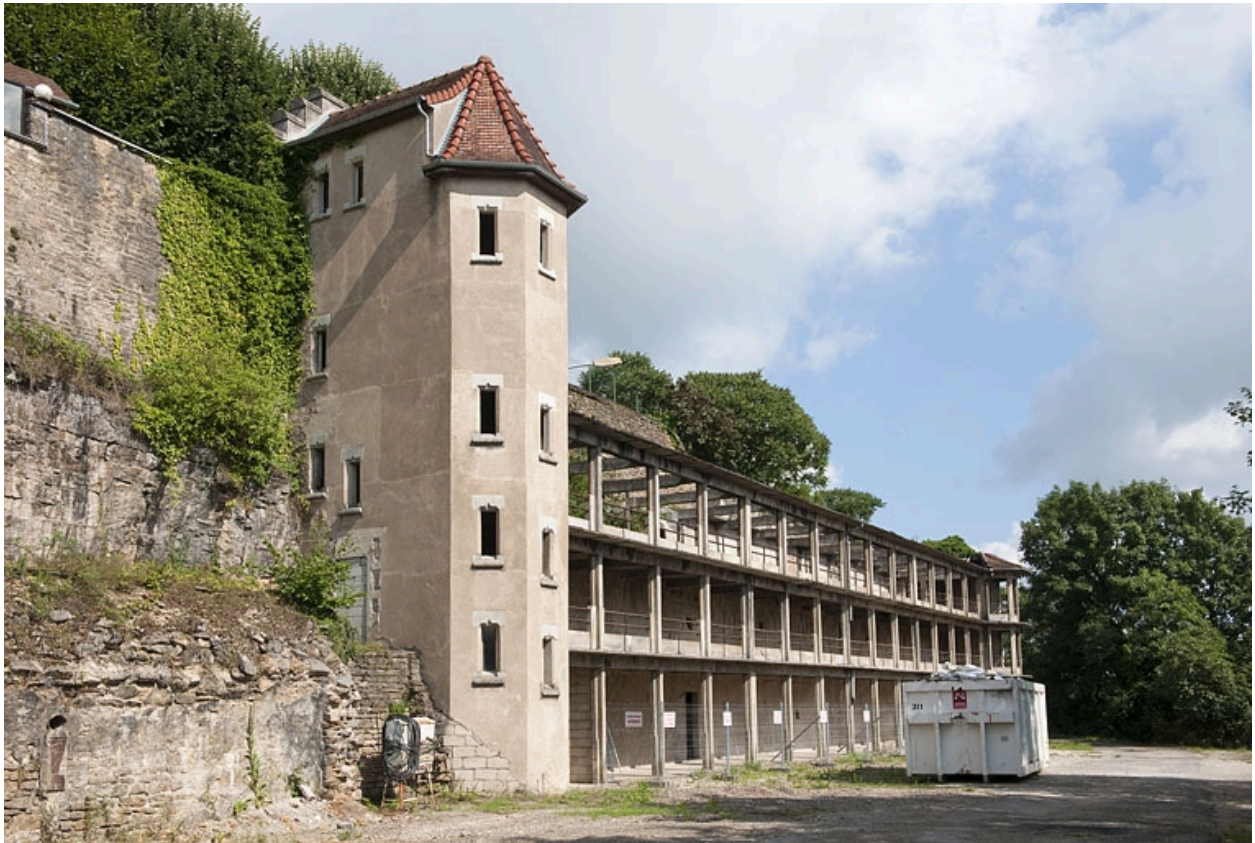
Bâtiment (H), vue rapprochée de la galerie.
