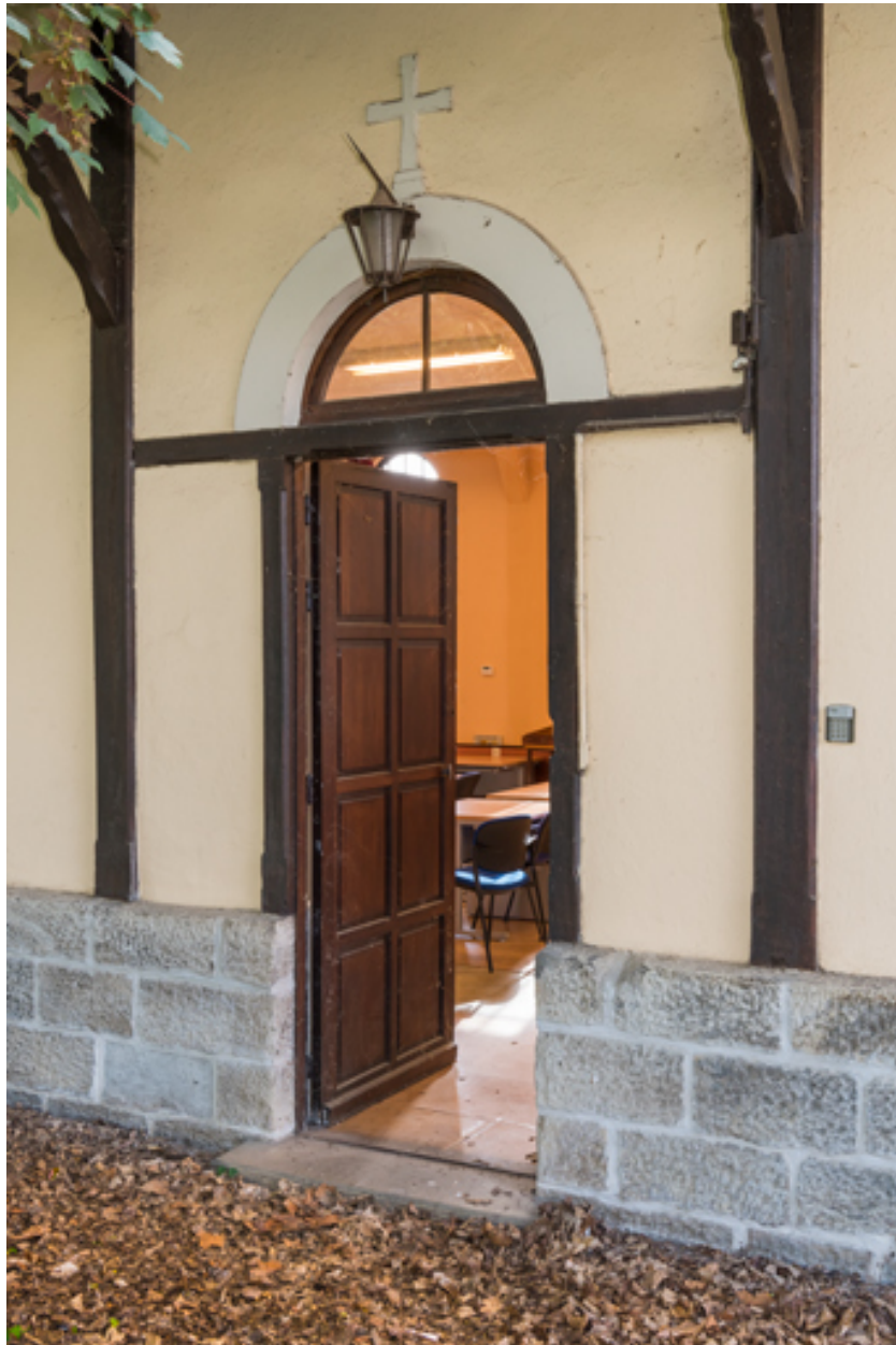
Entrée de la façade est. Vue de trois quarts.
