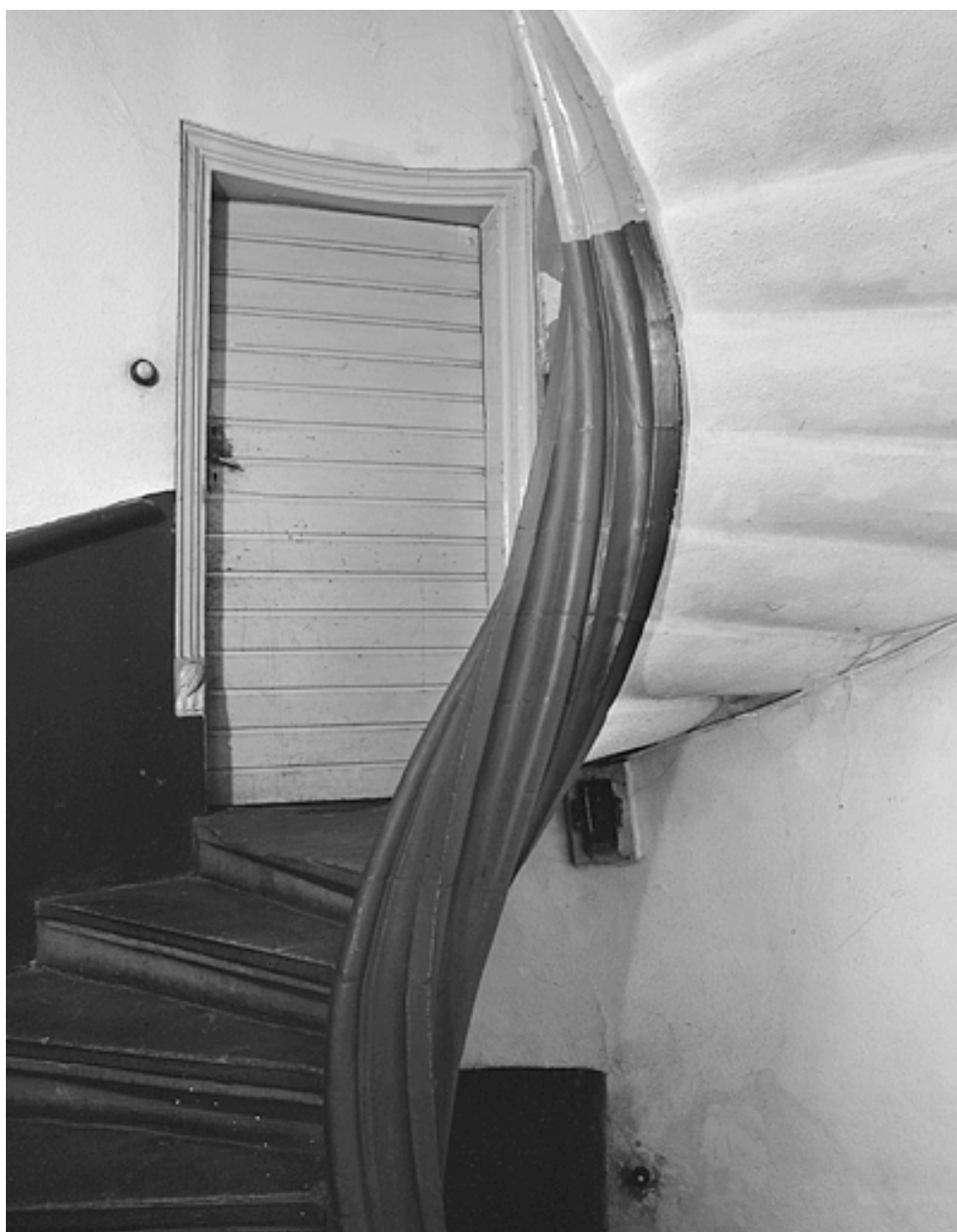
Escalier. Porte du premier étage.
