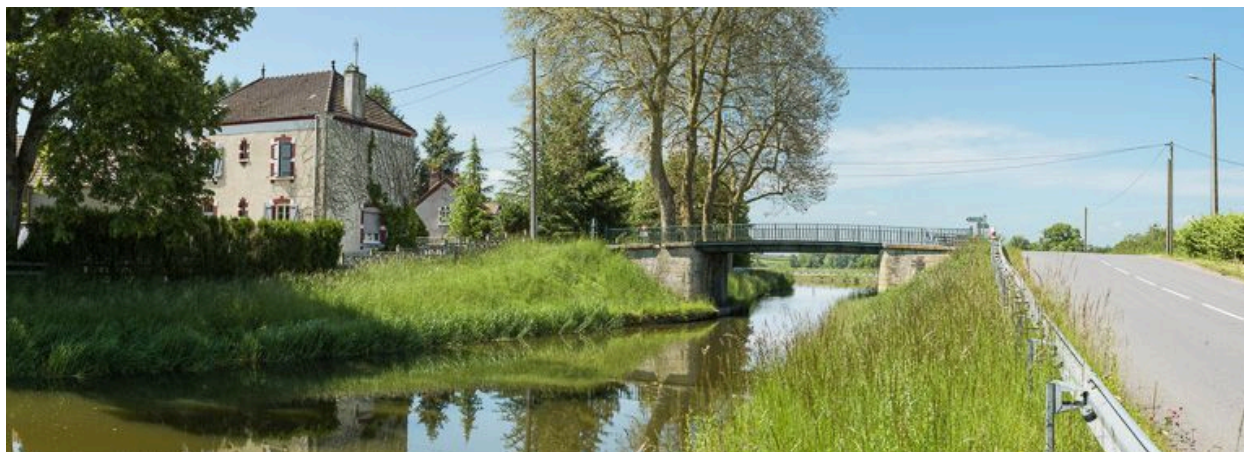
Vue d'ensemble du pont routier isolé des Vernes à Pouilloux.
