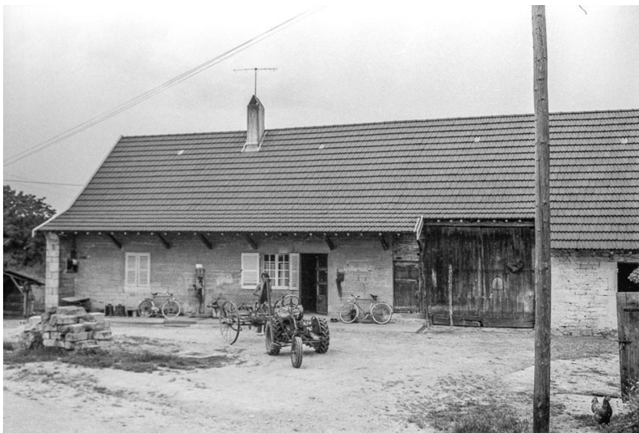
Façades antérieure vue de face.
