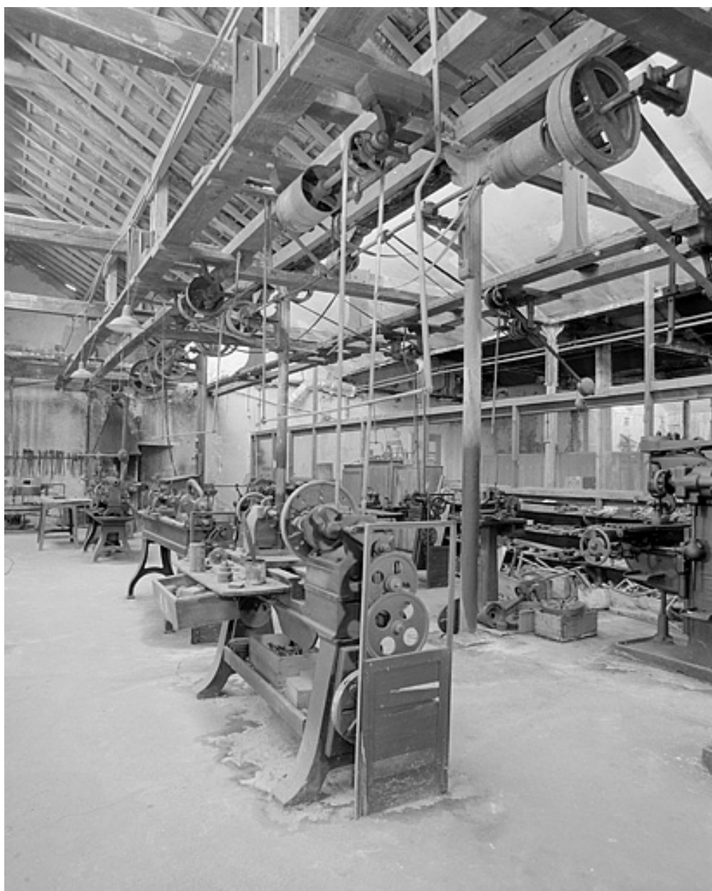
Atelier de mécanique. Distribution par courroies verticales.
