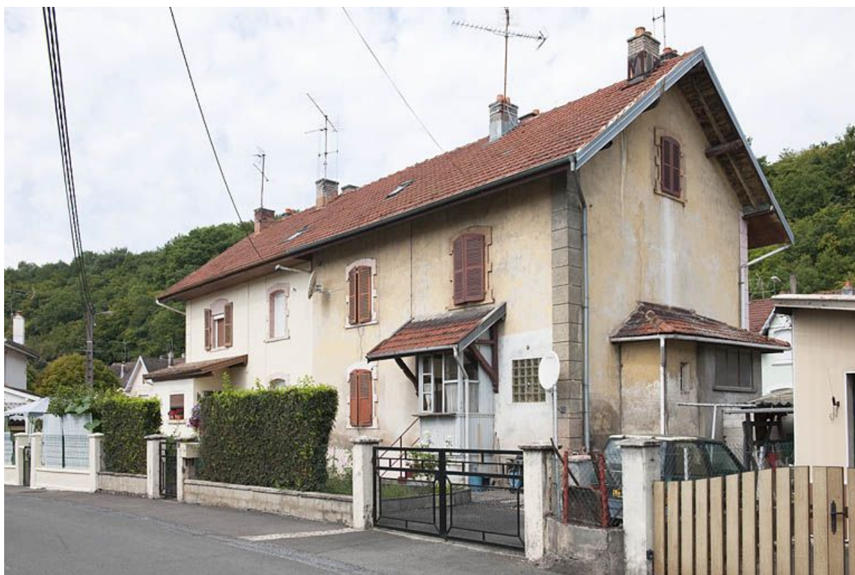
Habitation à 4 logements vue de trois quarts.
